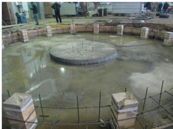
Рис. 19. Фундамент под сборку ЭМС и вакуумной камеры
