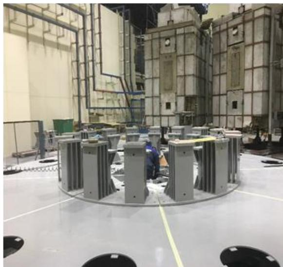
Рис. 10. Монтажная подставка вместе с опорами для катушек ОТП и вакуумной камеры
