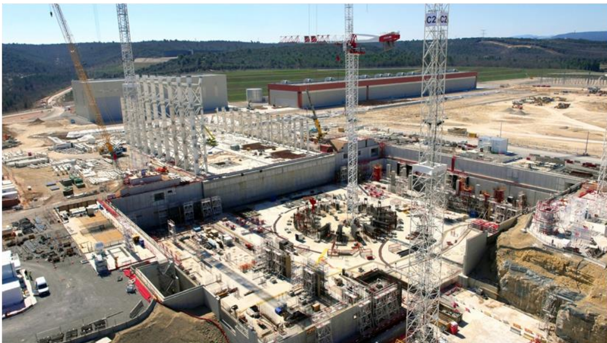
Рис. 10. Общий вид строительной площадки ИТЭРа. 2015 г.
