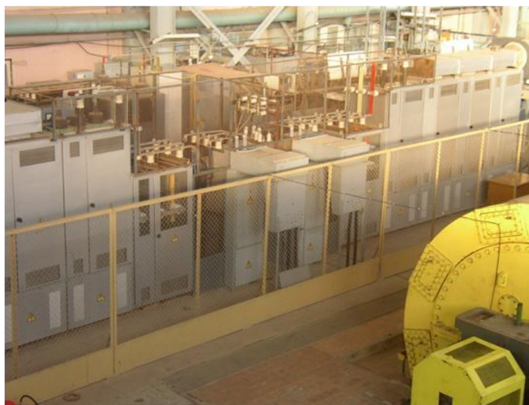
Рис. 11. Силовые полупроводниковые выпрямители с использованием тиристоров с воздушным охлаждением
