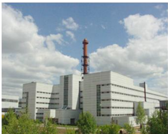
Рис. 1. Здание установки ТСП
